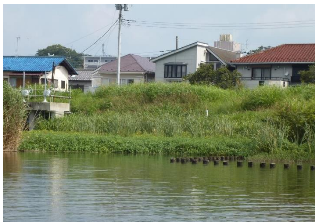
② 若松第4樋管
